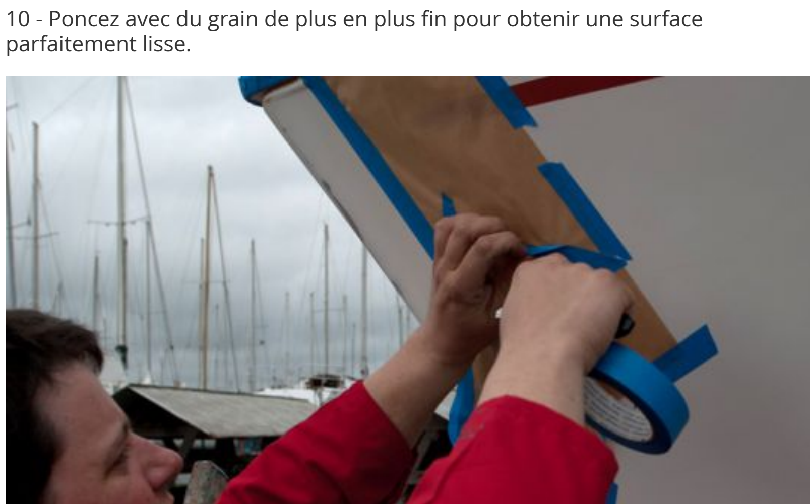
Réparer une rayure dans du gelcoat
