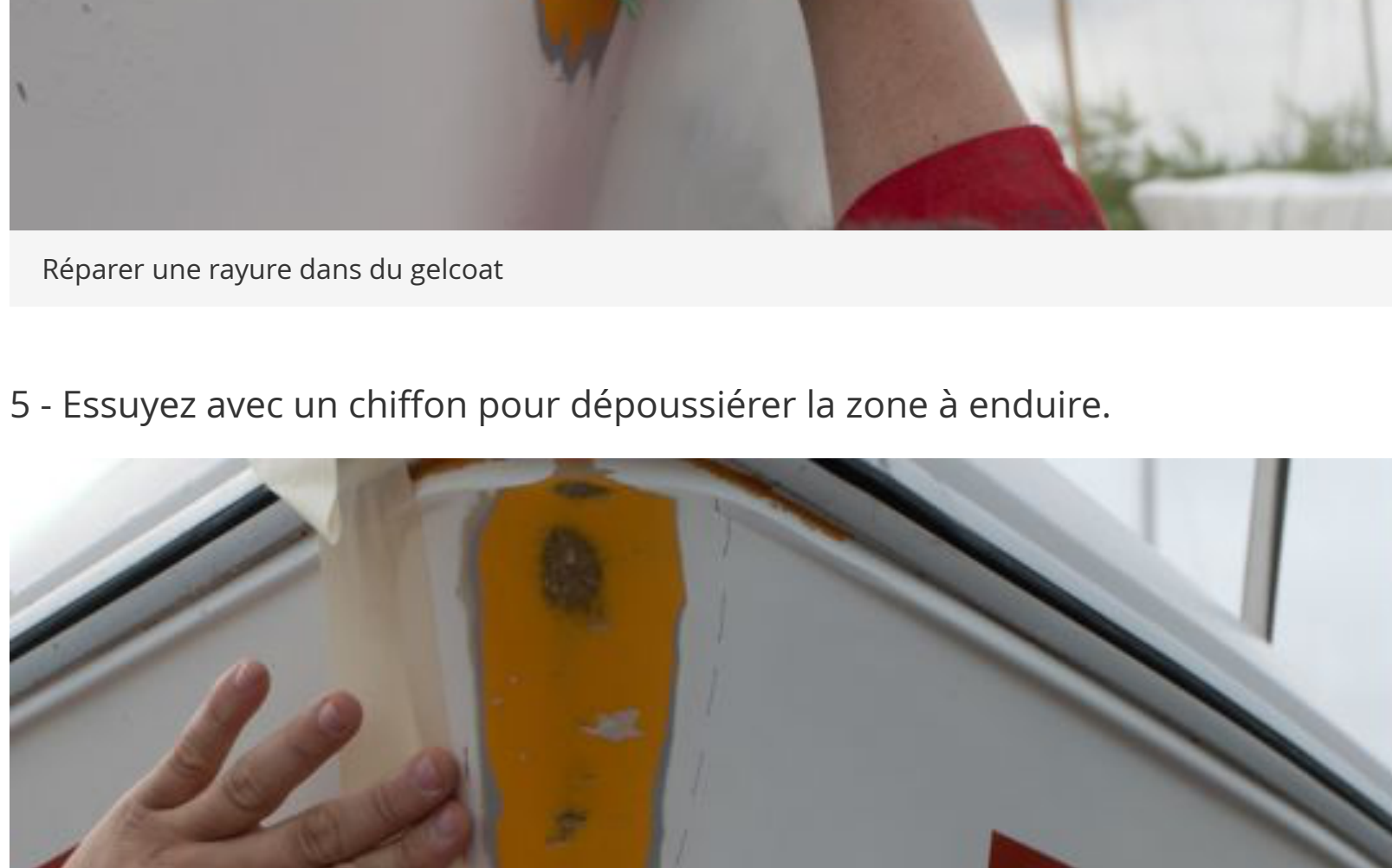
Réparer une rayure dans du gelcoat
